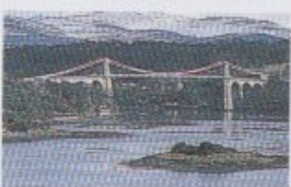
el puente bridge
